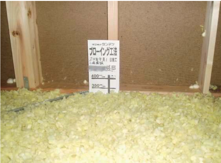
天井裏：吹込断熱材プローイング 300mm
